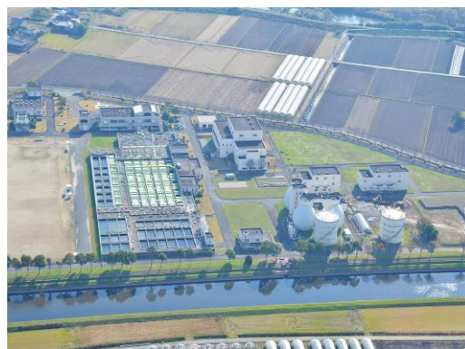
南部浄化センター（安武町）
