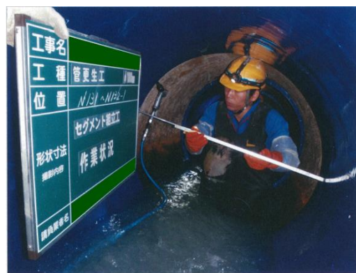
下水道管の内面更生
